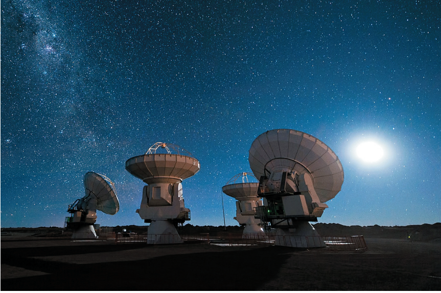
▲ Foto 4: Atacama çölü, Şili'de kurulu teleskop. Algılayıcı olarak süperiletken bolometreler kullanılmaktadır. 3
